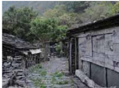
圖6.台灣世界遺產潛力點：屏東排灣族石板屋聚落 Figure 6. Potential world heritage sites in Taiwan: Slabstone house village of Paiwan, Pingtung County 臺灣排灣族建築形式有石板建築和茅草屋頂建築兩種形式，石板建築分布大致在屏東縣士文溪以北，七佳舊社在此範圍內，住居風格可為此類建築代表，為代表性聚落。 (資料來源： http://taiwanpedia.culture.tw )
